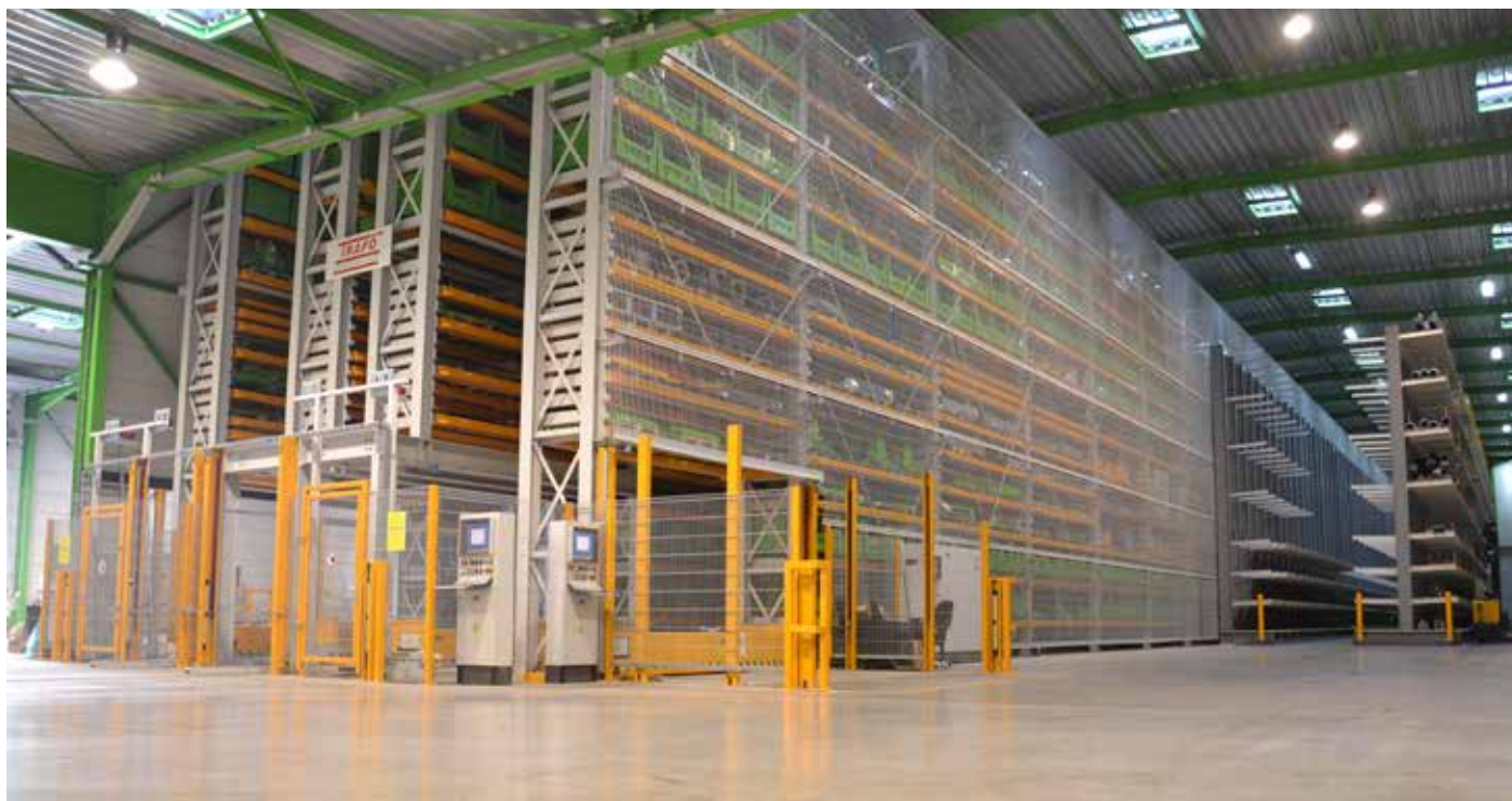
Automatyczny magazyn o kubaturze 28.000 m 3
