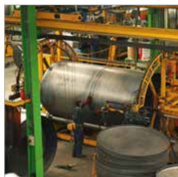
Łączenie segmentów i dennic zbiorników
